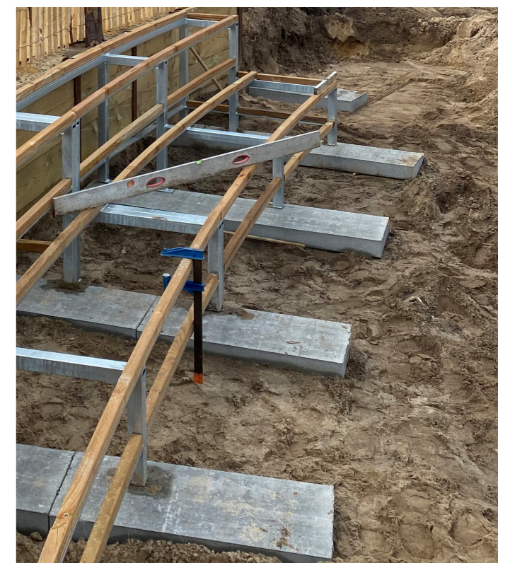
Fondations béton posées, Aménagement durable de la lette des Bourdaines, D'une Ville à l'Autre..., Seignosse (40), 2024
