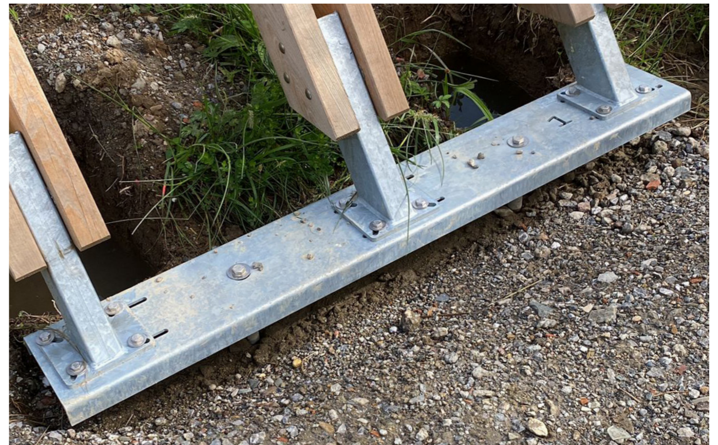
Longrine métallique sur pieux vissés, Parc de la médiathèque de Saint-Pierre-d'Irube, D'une Ville à l'Autre..., 2026
