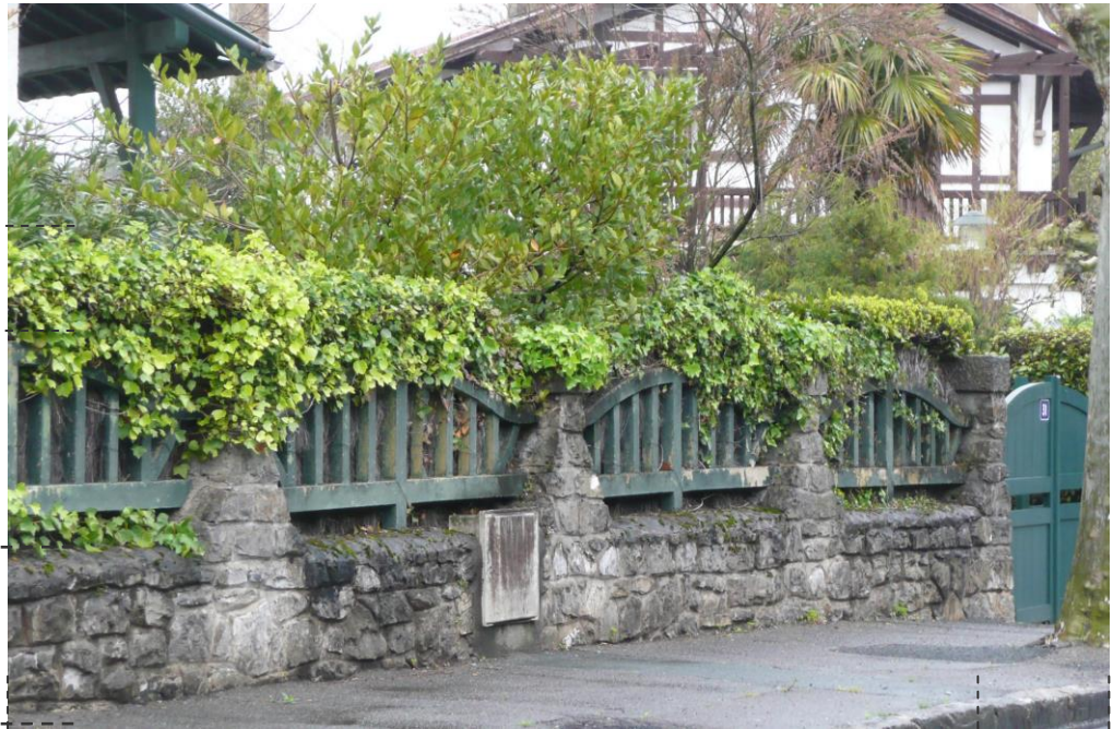
La partie courante de la clôture
