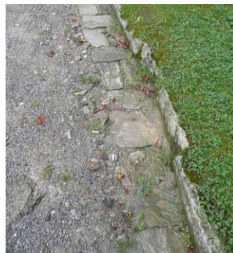
Matériaux : fil d'eau, bordure en pierre, chemin et accotement stabilisé, herbe ...
