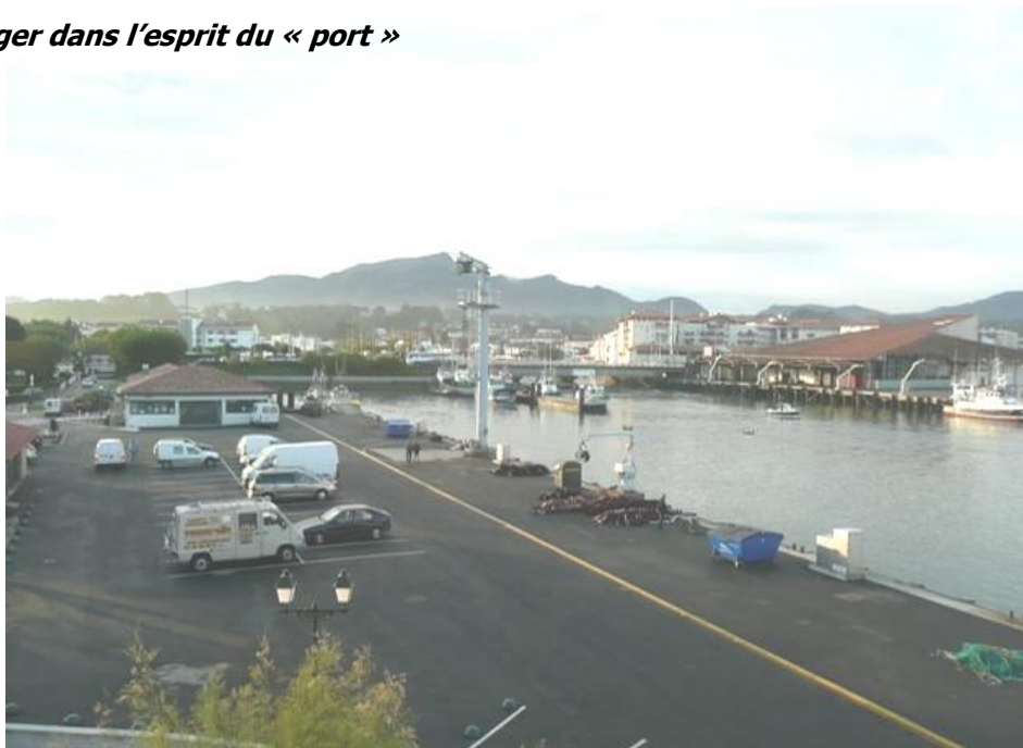
Aménagement des quais et des petits bâtiments dans l'esprit du « port » : cordes, voiles...
