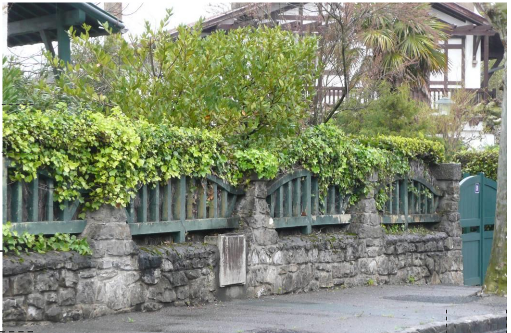
La partie courante de la clôture
