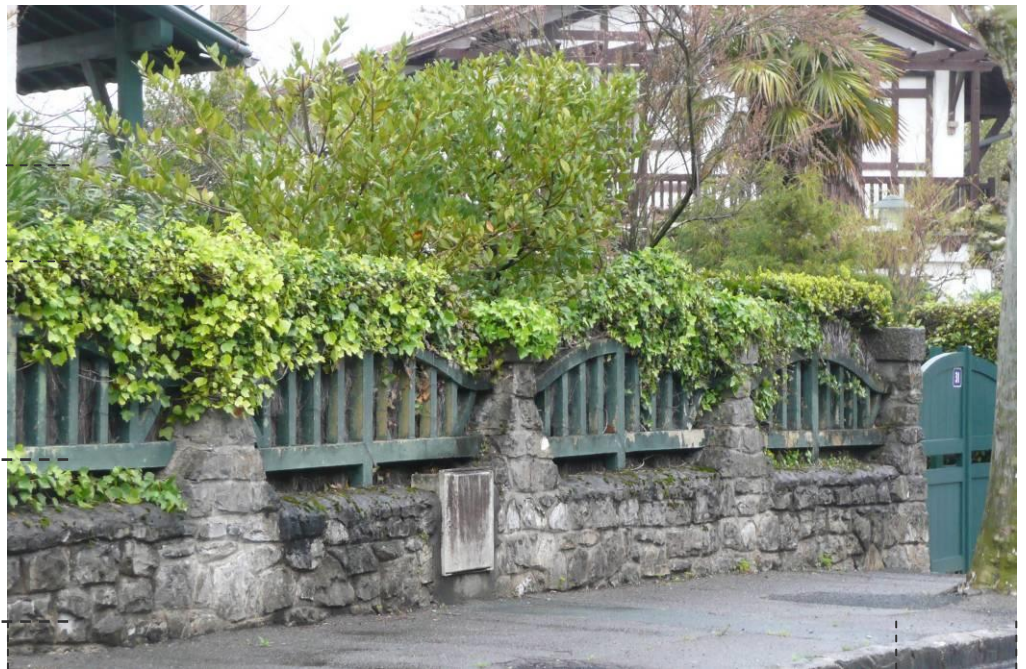
La partie courante de la clôture
