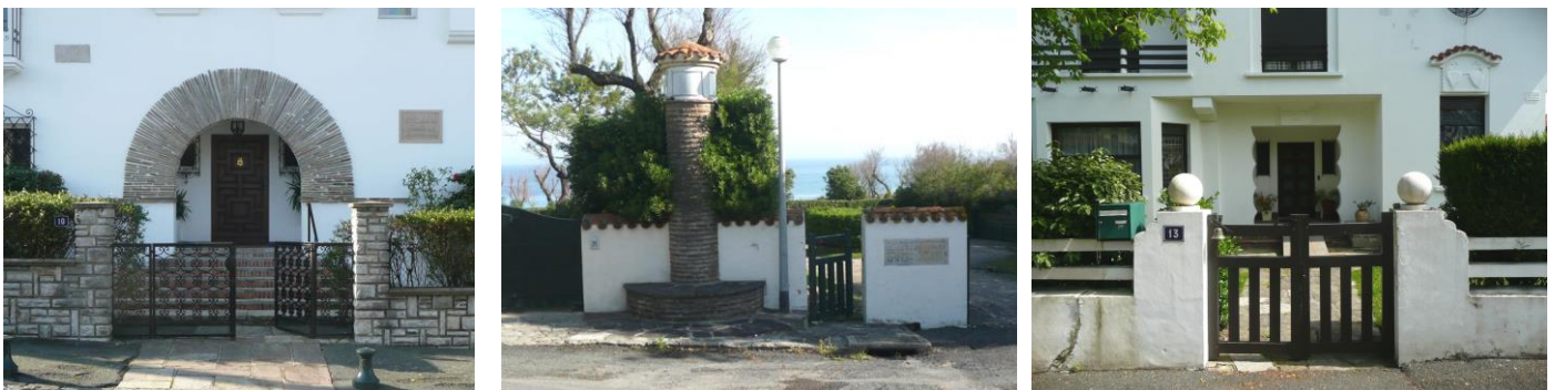
Variété de dessin, de matériaux... exemples à Aïce Errota, Sainte Barbe, Les Fleurs
