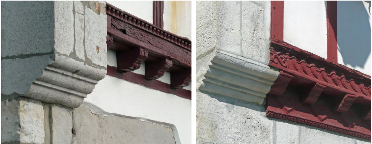
Encorbellement à trois ressauts en pierre et poutre décorée de motifs traditionnels sur consoles en bois mouluré.
