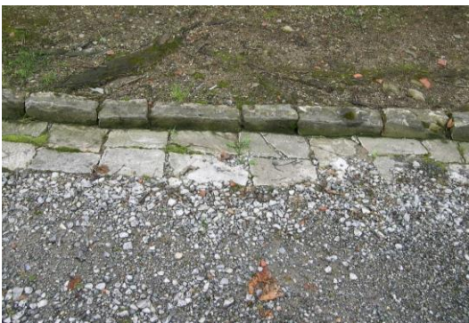
Matériaux : fil d'eau, bordure en pierre, chemin et accotement stabilisé, herbe ...
