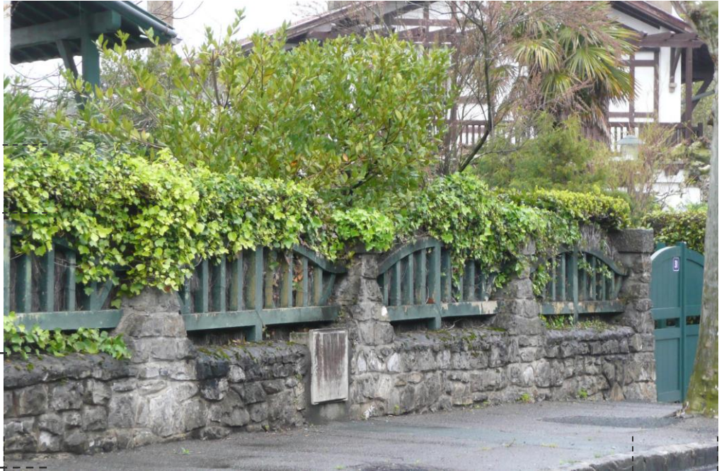
La partie courante de la clôture
