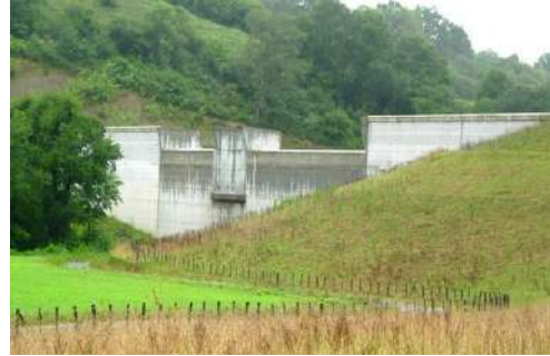
Bassin écrêteur de Lurberria (source : Centre Pyrénéen des Risques Majeurs)
