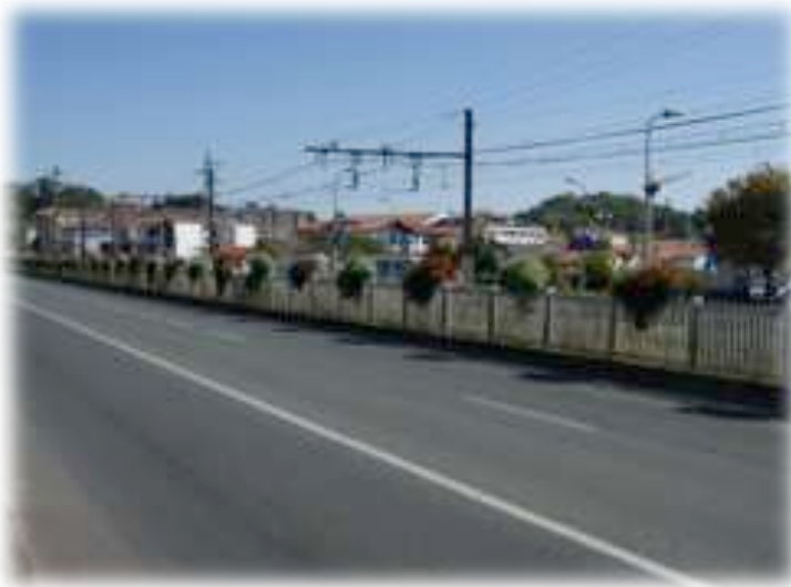
La rupture de la voie ferrée
