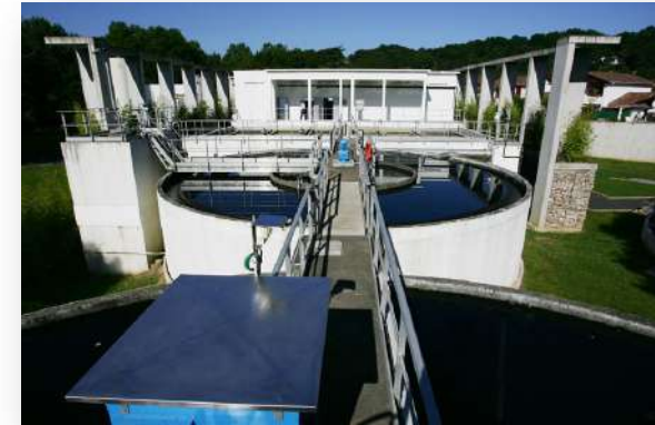
La station de production d'eau d'Helbarron
