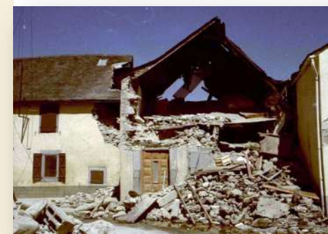
Dégâts du séisme d'Arette (1967)
